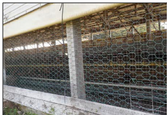
畜舎のネット整備
